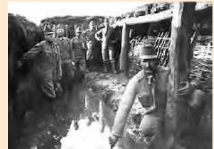
■ Австрійські траншеї, залиті водою
