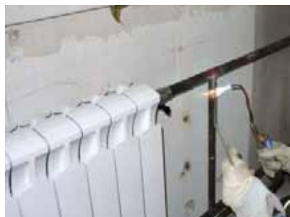
Мал. 10 Газозварювальні роботи за допомогою етину
