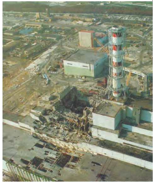
↑ Зруйнований четвертий реактор ЧАЕС
