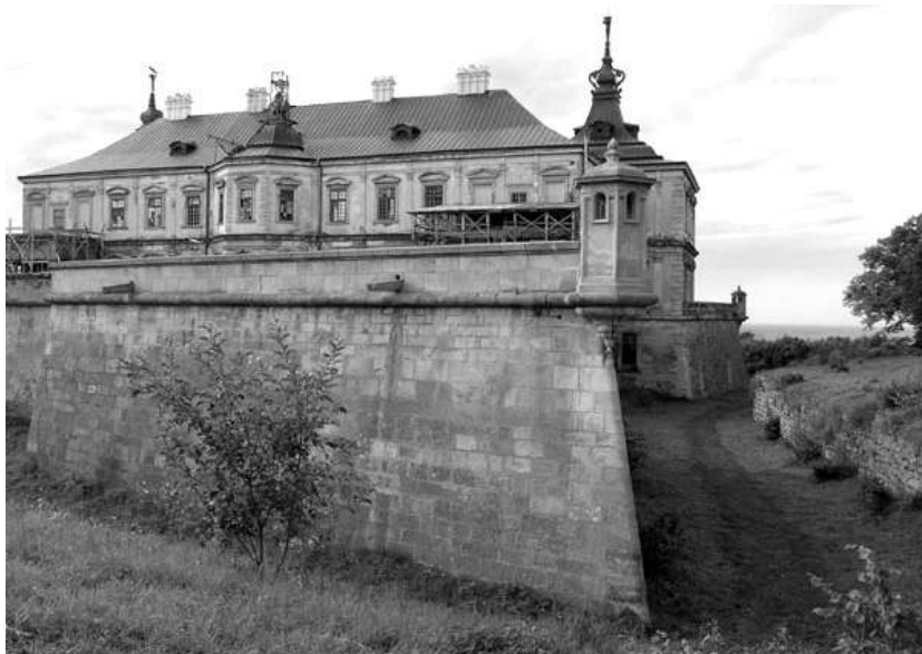
Один із спроектованих Г. де Бопланом кутових бастионів Підгорецького палацу, оборонна вежа-кавалер якого внаслідок пізніших перебудов набула романтично-декоративного вигляду.
